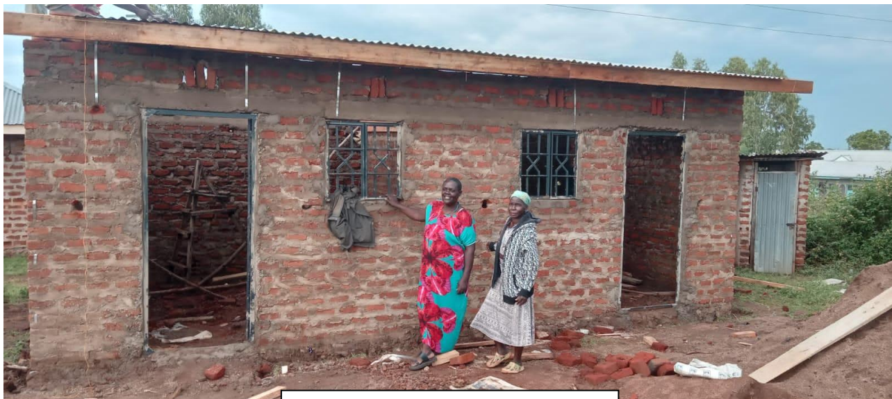
Een community center in aanbouw
